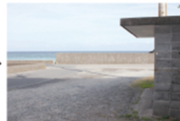
違法看板撤去後の写真。
